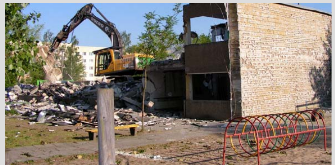
Teilrückbau der Kita „Musikspielhaus“ [Foto: Beschäftigungs- und Sanierungsgesellschaft Guben]
