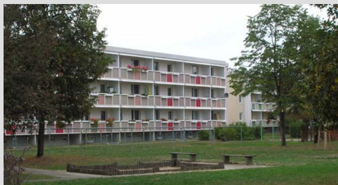
Fertigstellung des Geschossrückbaus in der Kaltenborner Str. im WK I [Foto: Gubener Wohnungsgesellschaft mbH]
