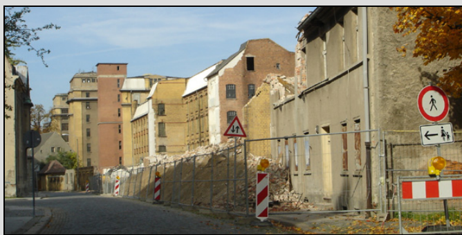
Gebäudeabbruch an der Südspitze der Gubener Wolle. [Foto: Stadt Guben]
