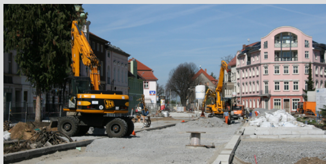
Bauarbeiten in der Berliner Straße [Foto: Ernst Basler + Partner GmbH]
