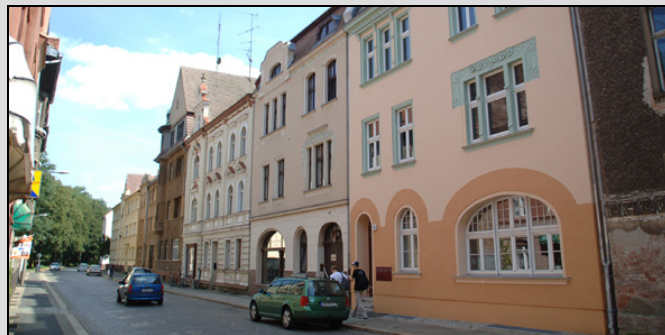
Sanierungserfolge in der Alten Poststraße [Foto: Foto-Werner]
