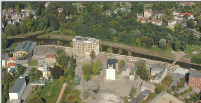
Das Areal der Gubener Wollereviere nach den Abbruchmaßnahmen [Foto: FOTO Werner]
