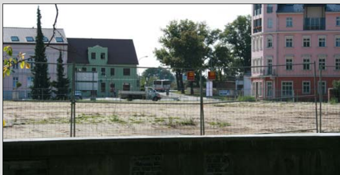
Schaffung neuer Entwicklungspotenziale durch den Abbruch der Industriebrache der ehemaligen Wäscherei Schlosser / jetzt AKSON [Foto: Ernst Basler + Partner GmbH]
