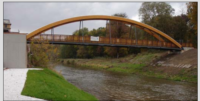
Fußgängerbrücke zur Theaterinsel [Foto: Ernst Basler + Partner GmbH]
