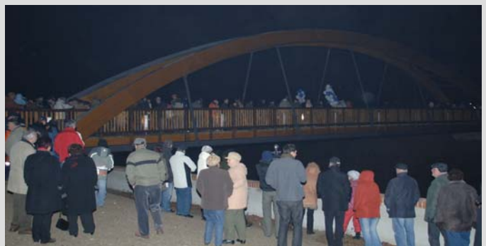
Zahlreiche Bürger kamen, schauten und nutzten die neue Brücke für eine schnellen Besuch in der Nachbarstadt (Foto: Stadt Guben)
