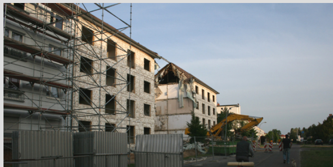
Segment- und Geschossrückbau in der Erich-Weinert-Straße 8-11 [Foto: Ernst Basler + Partner]
