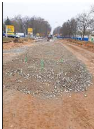
Einbau der ungebundenen Tragschichten.
