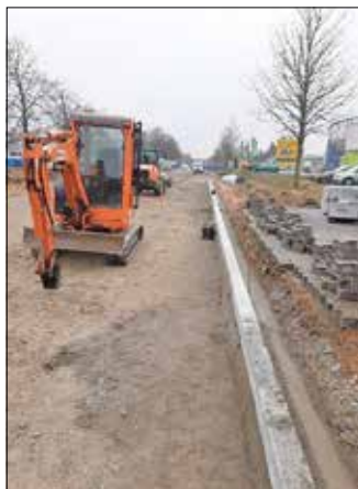
Gesetzte Bordanlagen in der Karl-Marx-Straße. Fotos: Stadt Guben,ml
