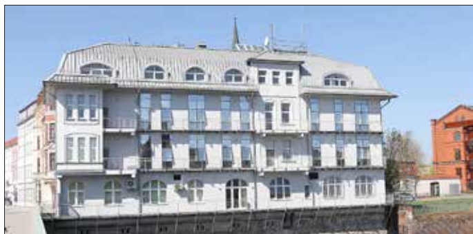
Bundes- und Landespolizei arbeiten in Guben unter einem Dach zusammen. © Laura Lehmann
