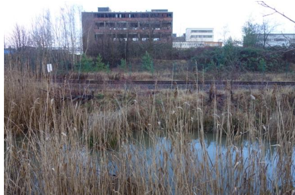
Abbildung 6: Parallel verlaufende Anschlussbahn und Regenwasserrückhaltebecken
