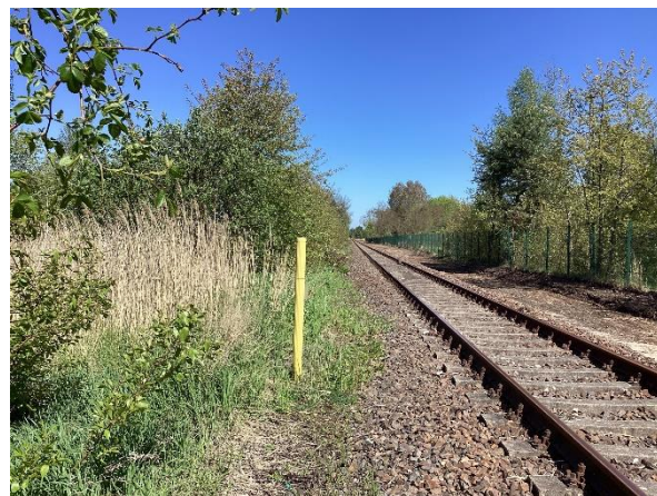
Abbildung 5: Gleistrasse mit begleitenden Gehölzen (Blick nach Norden)
